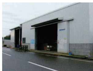
廃棄物一時保管所
