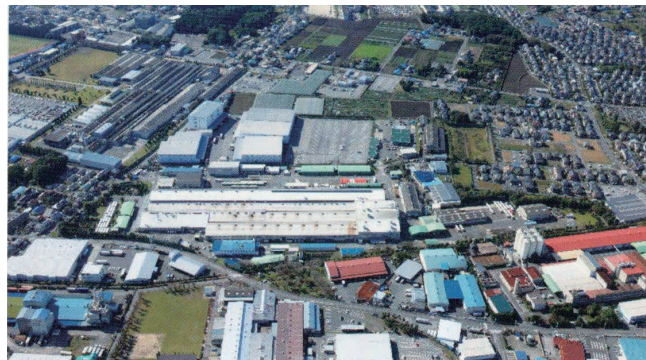
宇都宮工場 敷地面積 111,855m 2 建築面積 46,694m 2
