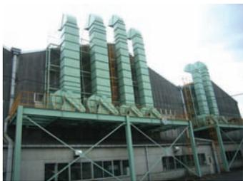
塗装ブースからの排気大気汚染防止法に則り、年2回のVOC測定を実施しています。
