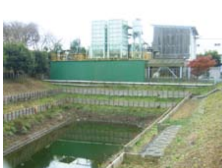
排水処理施設及び遊水池
