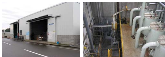
廃棄物一時保管所
