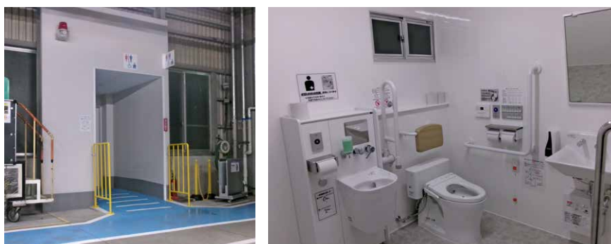
増設したオストメイト対応の多機能トイレ
